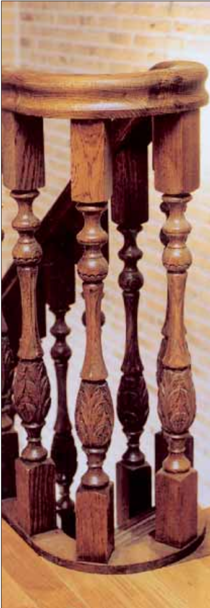
Balustres ou fuseaux
