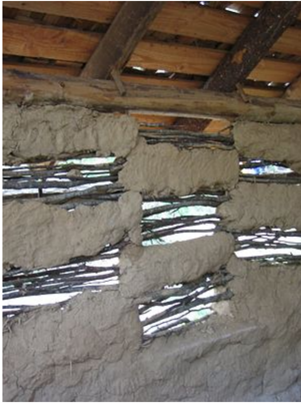
Mur en torchis au chantier médiéval de Guédelon (Yonne, France)
