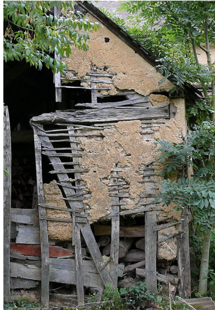
Vestige d'une ferme picarde, montrant la mise en œuvre du torchis.
