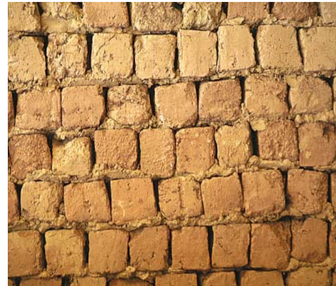
Mur en adobe
