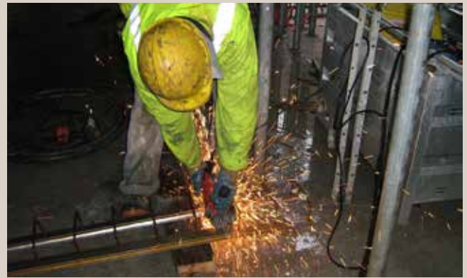
Découpe de boîte d'attente à la tronçonneuse.
