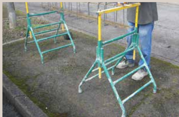
Atelier de ferrillage de linteaux BA avec tréteaux réglables en hauteur.
