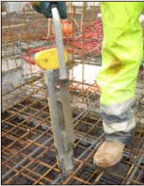
Ligatureur mécanique d'armatures.
