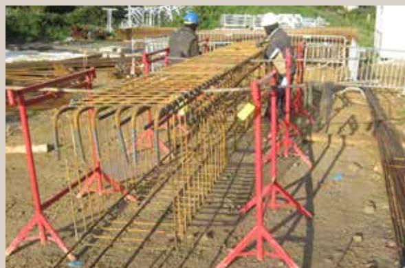
Atelier de ferrillage de poutres BA avec tréteaux fixes.
