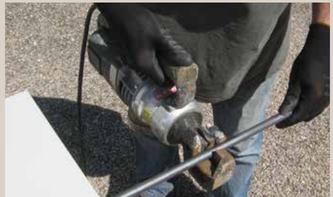
Découpe d'une barre filante à hauteur d'homme.
