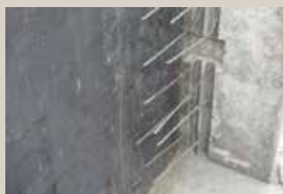
Boîte à support amovible retirée et armatures en attente dépliées.
