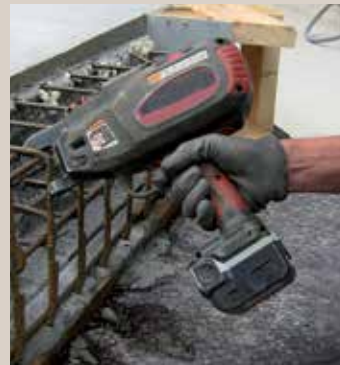
Ligatureur électrique d'armatures.
