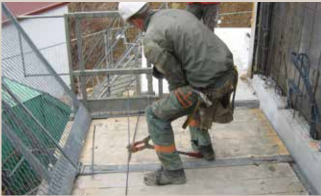
Découpe de barre filante au coupe-boulon.
