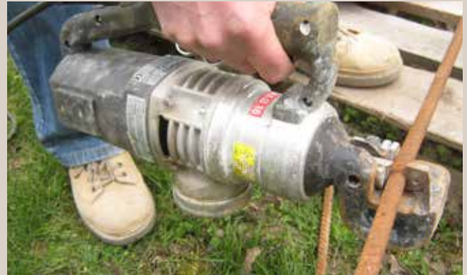
Découpe de barre filante à la cisaille électrique.
