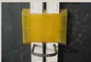
Boîte à support amovible fixée contre un coffrage métallique avec des aimants.
