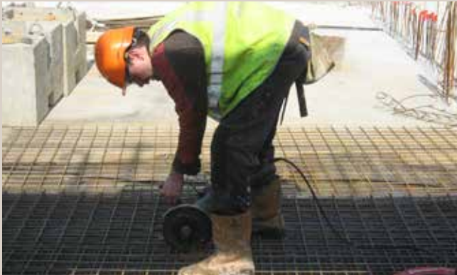
Découpe de treillis soudé à la tronçonneuse.
