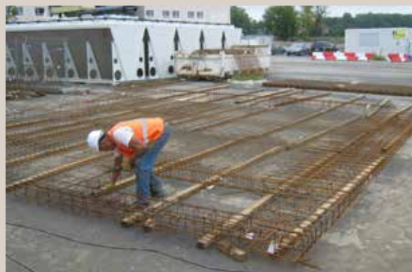
Assemblage d'un ferrillage de voile au sol.
