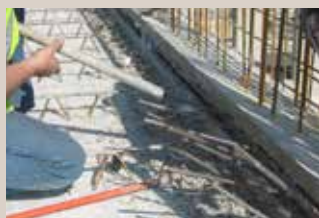
Dépliage des armatures en attente d'une boîte à support incorporé.
