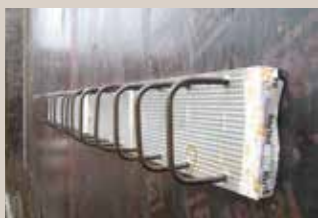
Boîte à support incorporé fixée sur un coffrage à peau bois.
