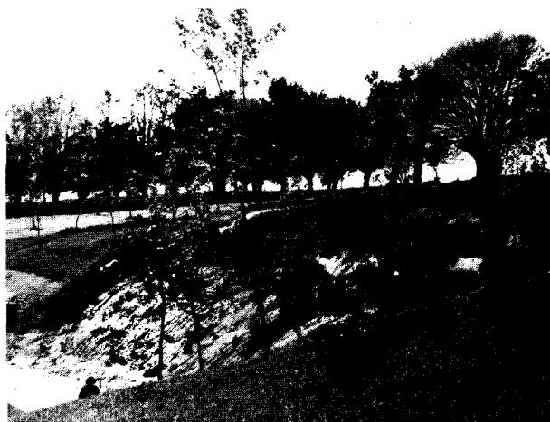
Fig. 1. — Rupture d'un talus de déblai en Normandie vingt mois après les terrassements. La hauteur est de 14 m, la pente 2/3, le matériau est une argile raide surconsolidée et fissurée, une nappe phréatique existe dans le terrain. On remarque que la rupture s'est produite avec un cercle de pied (une partie des matériaux ayant glissé a été enlevée pour rétablir le passage).
