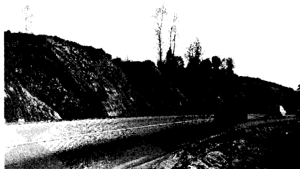
Accotements et talus instables! Déblai avec une pente voisine de 1/1 dans de la craie contenant de nombreuses poches d'argile. Toutes les poches se sont vidées.
