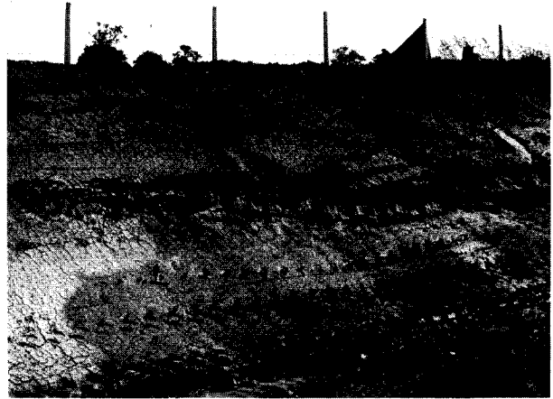
Ruptures de déblai d'environ trois mètres de hauteur sur plusieurs centaines de mètres dans les argiles altérées de l'Oxfordien. La partie supérieure qui n'a pas glissée, est du limon (autoroute A 13).
