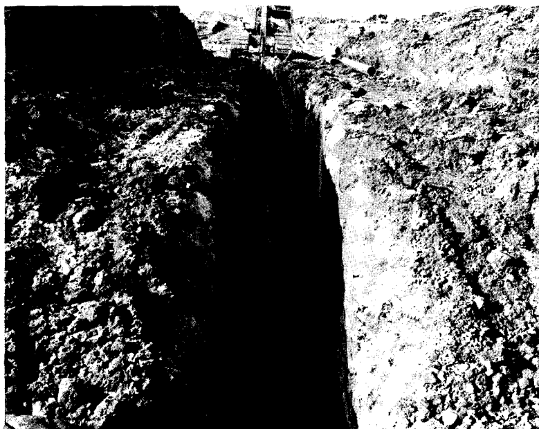
Fig. 13. — Tranchée drainante longitudinale.
