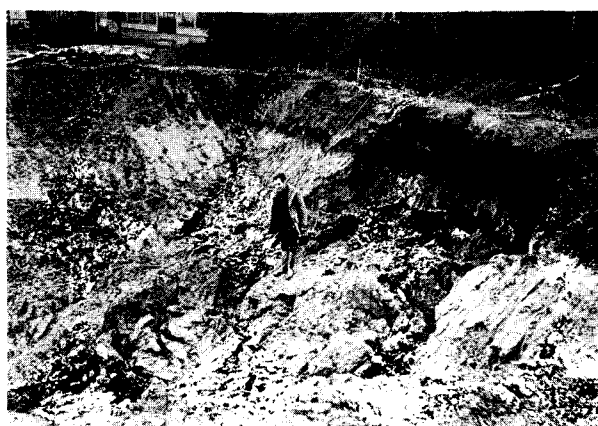
15 h 10. Fin du glissement. L'affaissement total en tête est de l'ordre de 1,80 m.
