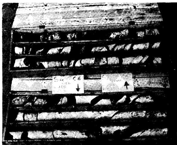
Fig. 6. — Sondage carotté dans un gneiss. Les premiers mètres sont très fracturés (RQD = 20%) alors que les derniers mètres correspondent à un rocher peu fracturé (RQD = 80%).
