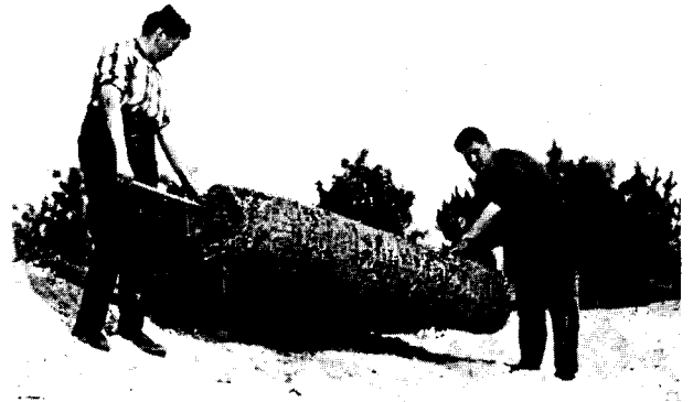
Fig. 8. — Pose d'un paillason Grünling.
