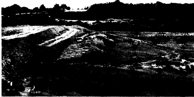
Fig. 1. — Vue générale du glissement de Pornic (rupture par poinçonnement).
