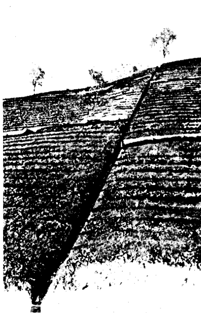
Fig. 5. — Autoroute Estérel-Côte d'Azur. Vue générale des fascinages et des cunettes centrales et latérales sur le revêtement de terre végétale.
