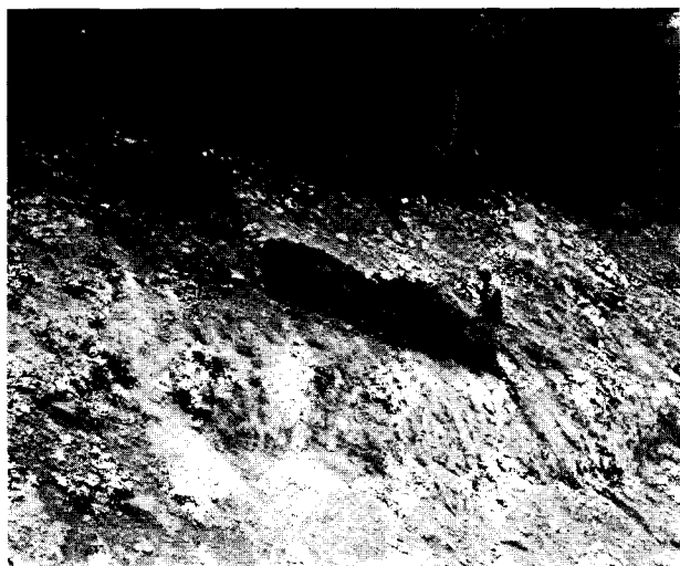
Fig. 10. — Désordres dus à un mauvais raccordement en crête de talus.
