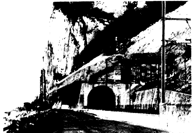
Fig. 17. — Ouvrage de protection de la voie ferrée Paris-Rome et de la RN 491 sur la rive est du lac du Bourget.
