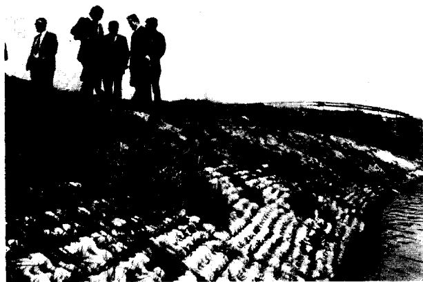
Fig. 9. — Vue d'une berge d'un canal protégée par Gobimatt et enherbée.
