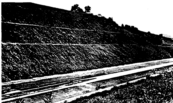
Fig. 1. — Autoroute A 7. Échangeur d'Avignon nord. Exemple d'esthétique paysagère.
