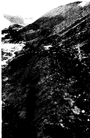
Fig. 16. — Désordres en pied de talus.
