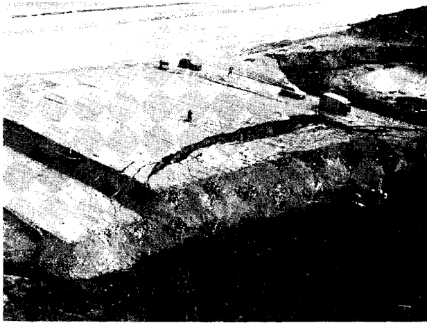
Fig. 5. — Vue d'ensemble du remblai de Lanester après le glissement.
