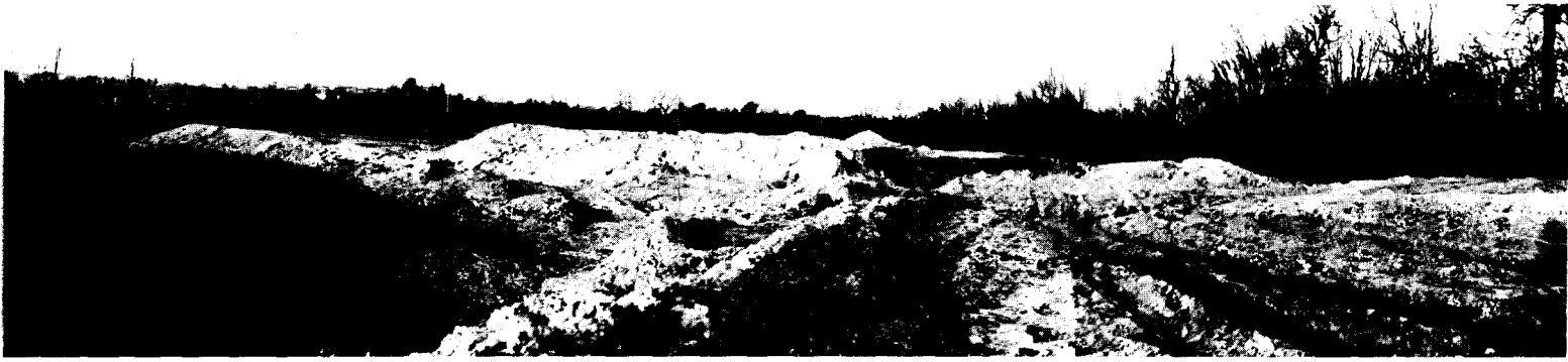
Fig. 5 a. — Photographie du remblai après les deux ruptures.
