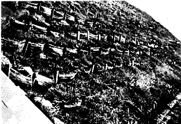
Fig. 4. — Exemple de fascinage avec des roseaux refendus.
