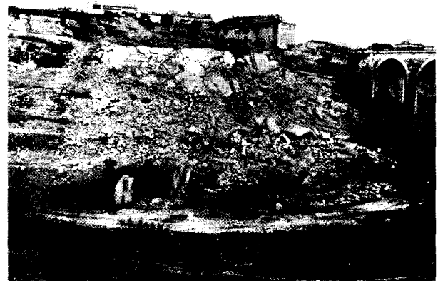
Fig. 11. — Éboulement d'une falaise en surplomb à Forcalquier.
