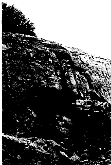
Fig. 2. — Faille de décrochement dans les grès des Vosges (déblai du canal d'Arzwiller).
