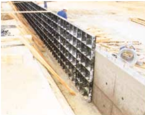
Coffrage transportable modulaire en plastique moulé.
