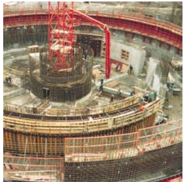
La complexité de certains ouvrages fait appel à des coffrages-ébénisterie, des coffrages métalliques structurés ou des coffrages de très grandes dimensions.
