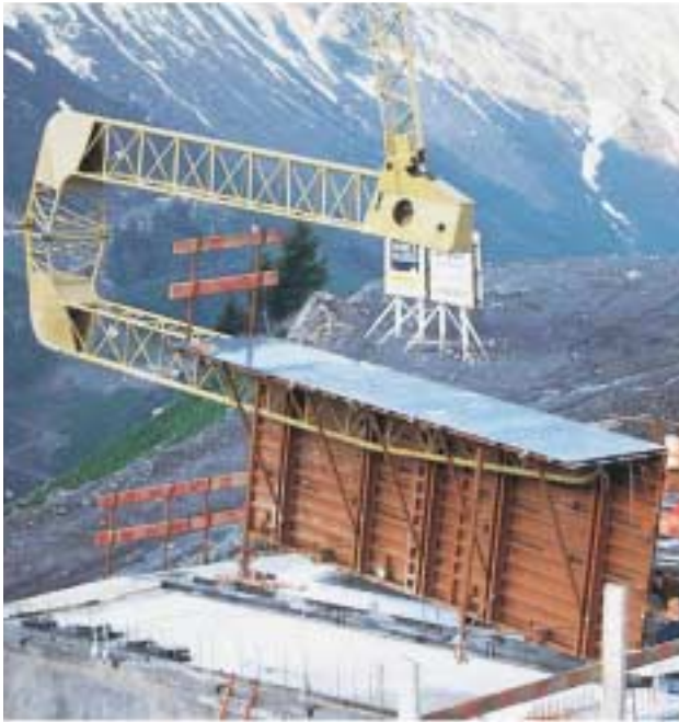
Coffrage tunnel demi-coquille.
