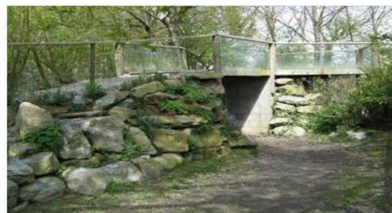
Enrochement servant à stabiliser un talus
