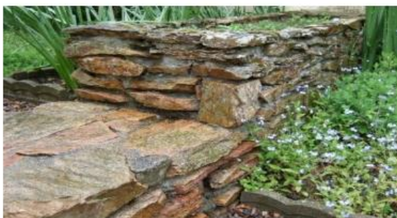
Fabrication de muret avec de la rhyolite
