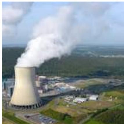
La fission des atomes d'uranium produit de la chaleur, chaleur qui transforme alors de l'eau en vapeur et met en mouvement une turbine reliée à un alternateur qui produit de l'électricité.
