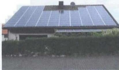
Toit solaire particulier
