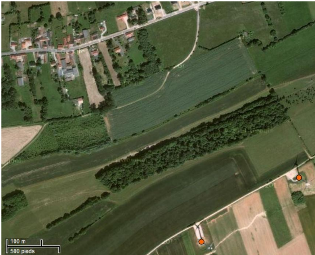
Vue satellite de l'une des fermes du site éolien de Fruges via googlemaps
