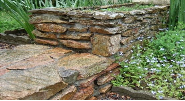
Fabrication de muret avec de la rhyolite
