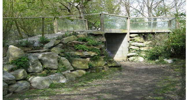
Enrochement servant à stabiliser un talus
