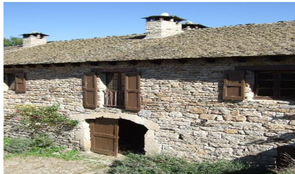
Fabrication de maison avec du granite
