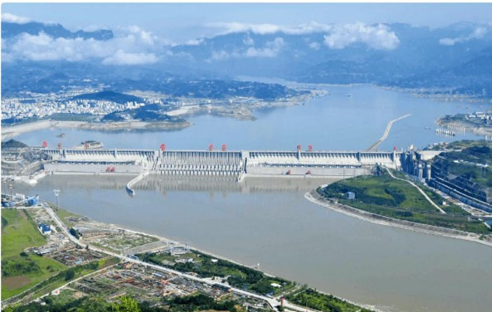
Le barrage des Trois-Gorges en Chine est le barrage qui délivre la plus grande puissance électrique au monde. Il est constitué de 32 turbo-alternateurs mis en mouvement par l'eau retenue par le barrage.
