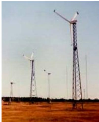
Les éoliennes à axe horizontal (ou à hélice) sont de conception plus simple et ont un rendement élevé. Elles sont dès lors plus répandues. Leurs caractéristiques communes sont d'être montées au sommet d'un pylône et d'être équipées d'un système d'orientation dans le vent. Elles sont appelées éoliennes à axe horizontal car l'axe de rotation du rotor est horizontal, parallèle à la direction du vent.
