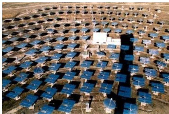
L'héliostat est amélioration du panneau solaire, en effet celui-ci possède les mêmes caractéristiques qu'un panneau normal avec en plus la capacité de pouvoir suivre le déplacement du soleil. Ce déplacement est rendu possible grâce à des moteurs qui entraînent l'axe soutenant le panneau photovoltaïque. Pour augmenter le rendement des panneaux solaires il existe en plus des champs d'héliostats.
