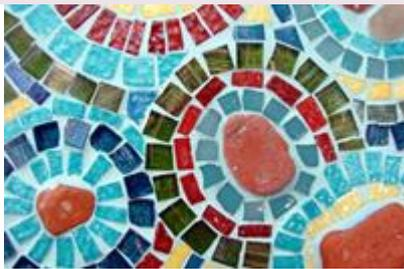
Le terme "mosaïque" définit non pas un produit, mais un assemblage d'éléments de petites dimensions formant une fresque ou reproduisant un dessin. Par extension, on désigne par ce terme les carrelages réalisés à l'aide de petits éléments de 1 à 5 cm de côté. Suivant la forme de ces éléments, l'assemblage peut être :
