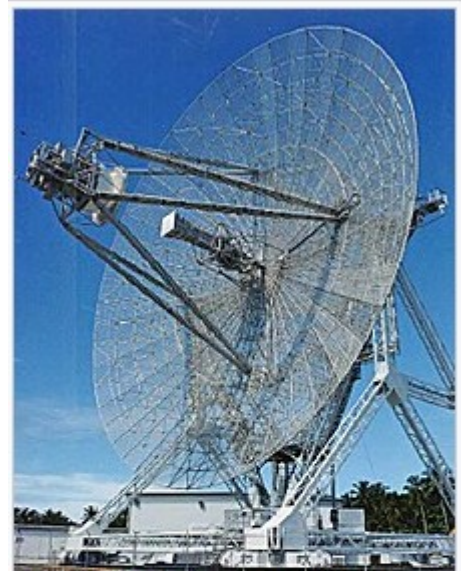
Cette antenne radar longue portée, connue sous le nom ALTAIR, est utilisée pour détecter et pister les objets spatiaux en conjonction avec le système anti-missiles balistiques sur le site Ronald Reagan Test Site localisé principalement sur l'atoll Kwajalein des Îles Marshall.
