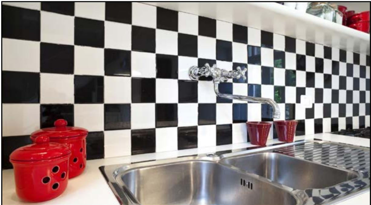
La faïence est de loin la plus utilisée pour les carrelages muraux. Il s'agit d'une céramique fine et donc très fragile. Sensible à l'usure et très rapidement griffée, elle ne sera que très rarement posée au sol ou alors dans un endroit avec très peu de passages.
