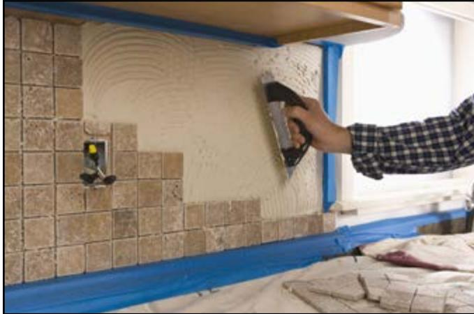
Lorsque vous carreliez une crédence, il faut commencer par un carreau entier au niveau du plan. Pour que le rendu soit parfait, il est préférable de carreler la crédence après la pose de vos meubles. La première étape consiste à poser les carreaux découpés à la dimension souhaitée. Il est important de respecter
