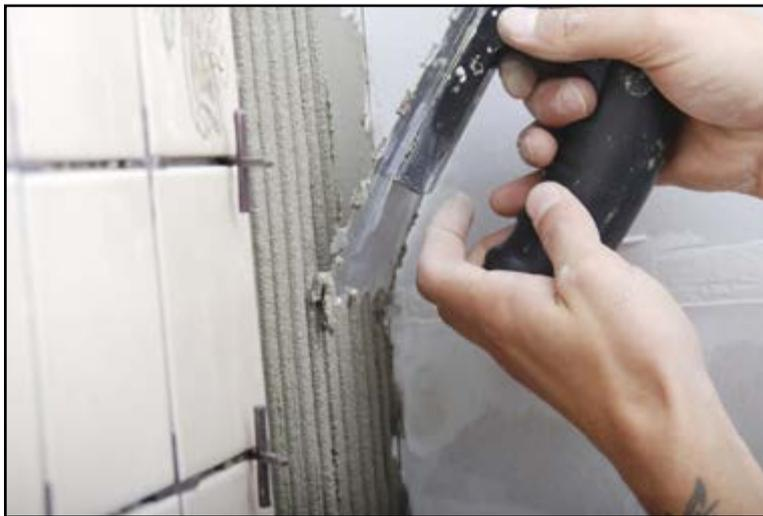
Il est temps de commencer la pose du carrelage mural, en progressant du bas vers le haut. Pour réussir la pose, le démarrage est capital : en général, le départ s'effectue avec un carreau entier au niveau du sol ou de la plinthe. S'il y a un lavabo, il faut faire démarrer le carreau entier dessus.
