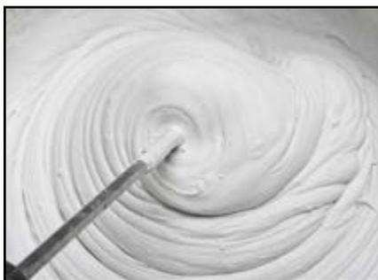
Pour la préparation de l'enduit, suivez scrupuleusement les instructions : vitesse de rotation du malaxeur et temps de pause. Versez l'enduit de ragréage sur 1 m<sup>2</sup> à 2 m<sup>2</sup> à la fois, puis étalez. Il est recommandé de commencer par le coin opposé à la porte de sortie et de terminer du côté de la porte. Veillez à bien répartir l'enduit le
