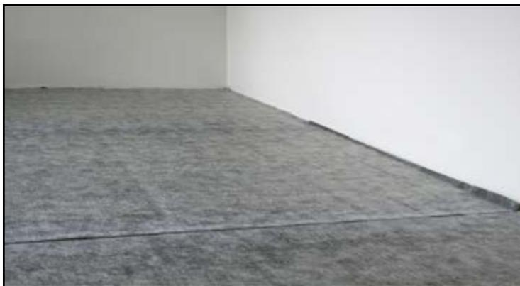
Les plaques d'une épaisseur inférieure à 12 mm présentent des propriétés acoustiques et/ou thermiques variables suivant les constituants : mousse polyéthylène, liège, fibres polyester... Elles se collent à l'aide d'un mortier spécifique, la pose et le
