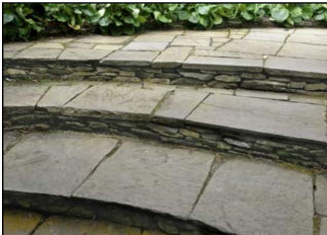
L'ardoise est une pierre métamorphique d'origine sédimentaire, constituée de minéraux, tels que le quartz, le feldspath, le mica, mais aussi l'hématite, le chlorite, le graphite... Elle est le résultat de la transformation de couches d'argile en schiste suite à des pressions géologiques, et se présente comme un empilement orienté de feuillets.
