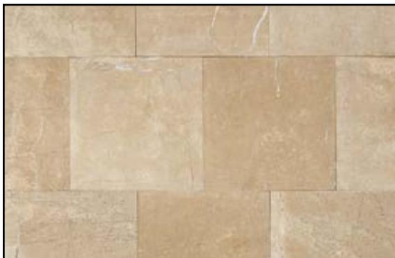
La pose à joints contrariés (ou à rupture de joints) est une pose droite de carreaux carrés identiques, présentant à chaque rangée un décalage d'un demi-carreau.
