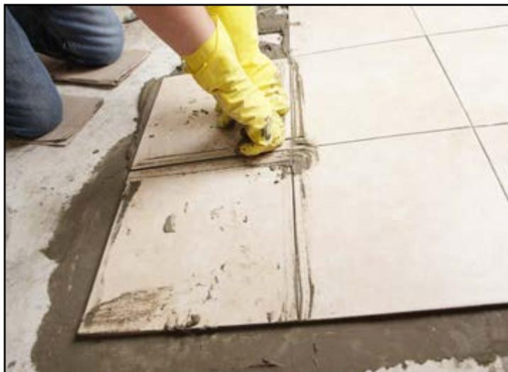
Des opérations peuvent être nécessaires au préalable, comme un ragréage en cas de support à aplanir ou encore une isolation sous le carrelage. Enfin, les joints et les plinthes constituent les dernières finitions de votre carrelage.
