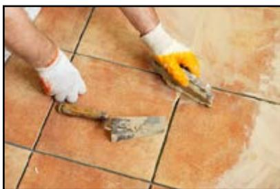
Le jointement du carrelage s'effectue après un temps de séchage d'environ 24 h si vous avez utilisé un mortier-colle à durcissement normal.
