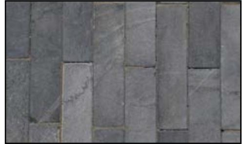
L'inconvénient principal du carrelage en ardoise est sa pose délicate. Veillez à manipuler les carreaux avec soin pour ne pas les ébrécher. De plus, un traitement hydrofuge est fortement recommandé après la pose.
