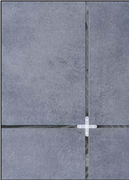
N'oubliez pas l'espace entre les carreaux (entre 1 mm et 10 mm). Il est recommandé d'utiliser des croisillons spéciaux en plastique, cela permet des espacements réguliers. La largeur du joint est fonction de la dimension du carreau et de l'effet recherché. Pensez à retirer les croisillons avant le durcissement complet de la colle.
