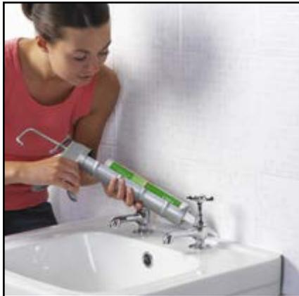
Si vos joints sont vraiment endommagés et donc plus du tout efficaces, vous pouvez éprouver la nécessité de les refaire. Pour cela, retirez la totalité de l'ancien joint à l'aide d'un grattoir sur toute l'épaisseur du carreau. Avant de refaire le joint, nettoyez très proprement l'interstice en retirant tous les résidus et dégraissez-le à l'acétone. Réalisez ensuite le jointement comme pour une pose initiale.
