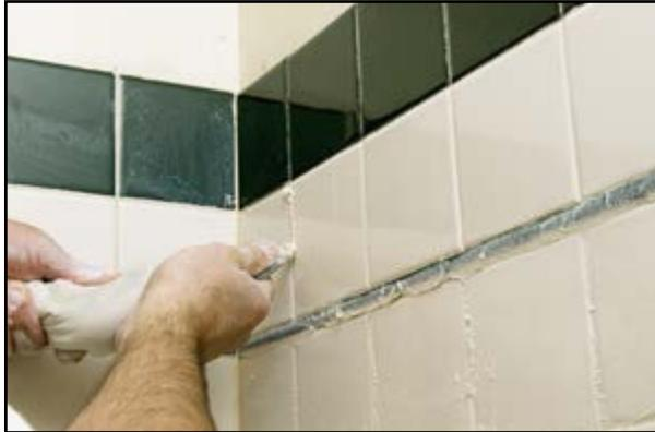
Le joint de dilatation diffère des joints classiques au mortier, mais est tout aussi primordial. Toute structure d'ouvrage se dilate, bouge, vit avec le temps et les variations de température. Le joint de dilatation divise la construction en parties indépendantes et permet ainsi d'absorber les écarts de dimensions des différents maté-
