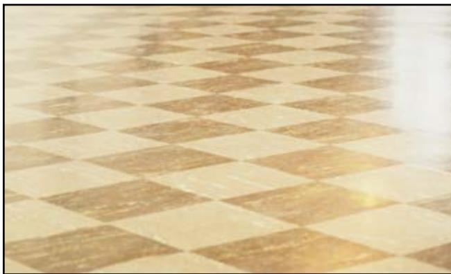
Tout d'abord, l'émaillage consiste en un dépôt d'une couche de verre (en fait une composition chimique à base d'oxyde de fer, d'étain, de manganèse) posée sur le carreau de terre cuite qui est recuit. Cet émail non seulement colore, mais octroie au carreau des caractéristiques esthétiques (nuance,
