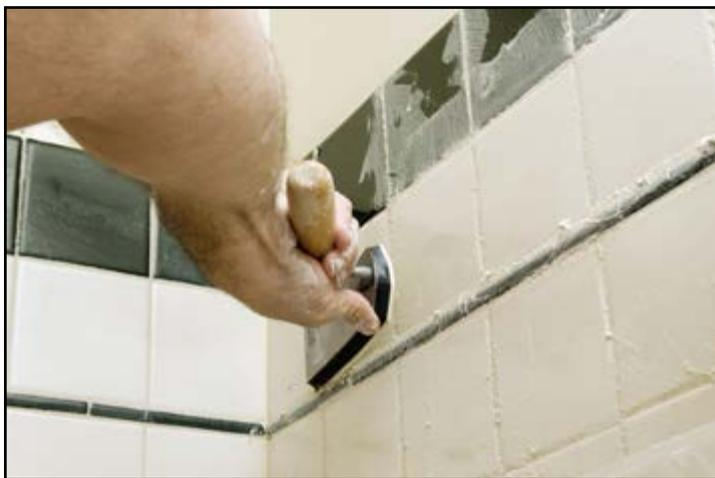
Pour réaliser le jointement, étalez généreusement, et en oblique, le mortier par surface d'environ 1 m<sup>2</sup> à l'aide de la raclette en caoutchouc. Il doit s'insérer dans l'espace libre entre les carreaux. S'il s'agit d'un carrelage mural, le raclage doit se faire horizontalement et verticalement.
